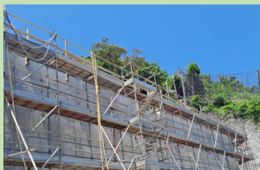
混凝土泥石壩建造工程 Construction of Rigid Barrier
